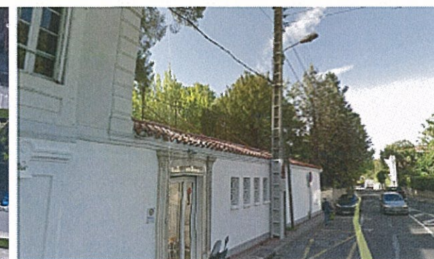
Rue de la pépinière Trottoirs
