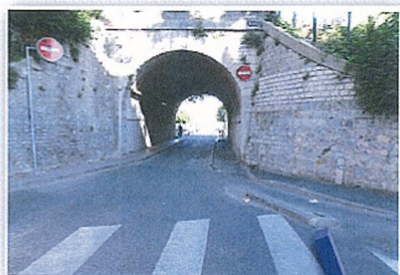
Pont du «Corum» Travailler la visibilité Séparation des usagers Emplacement des feux
