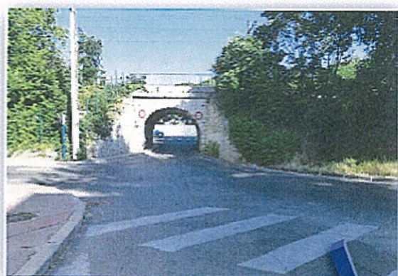
Pont «Val Marie» Élargir les trottoirs Synchronisation des feux
